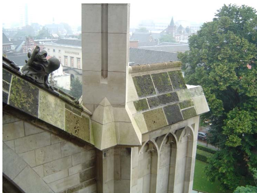
Verbeteren. Bij afzonderlijke restauratiefases door de eeuwen heen zijn allerlei natuursteen blokken van deze luchtboog en contrafort van de Sint-Janskathedraal in Den Bosch vervangen in het materiaal Saint- Joire, Ettringer tufsteen, Peperino Duro en Portlandstone. Door goed na te denken over de plaats van de voegen of het samenvoegen van onderdelen kan de technische staat van de constructie worden verbeterd.
