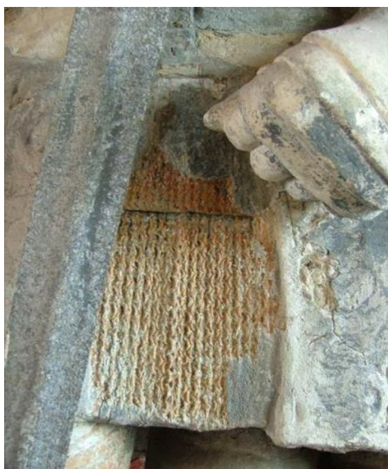
Conserveren. De beelden op het Veerse raadhuis dateren uit het begin van de zestiende eeuw en zijn gemaakt in een zachte kalksteen (Avendersteen). Ze hebben ongeveer 400 jaar de elementen getrotseerd, waarschijnlijk door het behandelen van de steen met een verf en verguldsel, waarvan op de foto nog restanten te zien zijn
