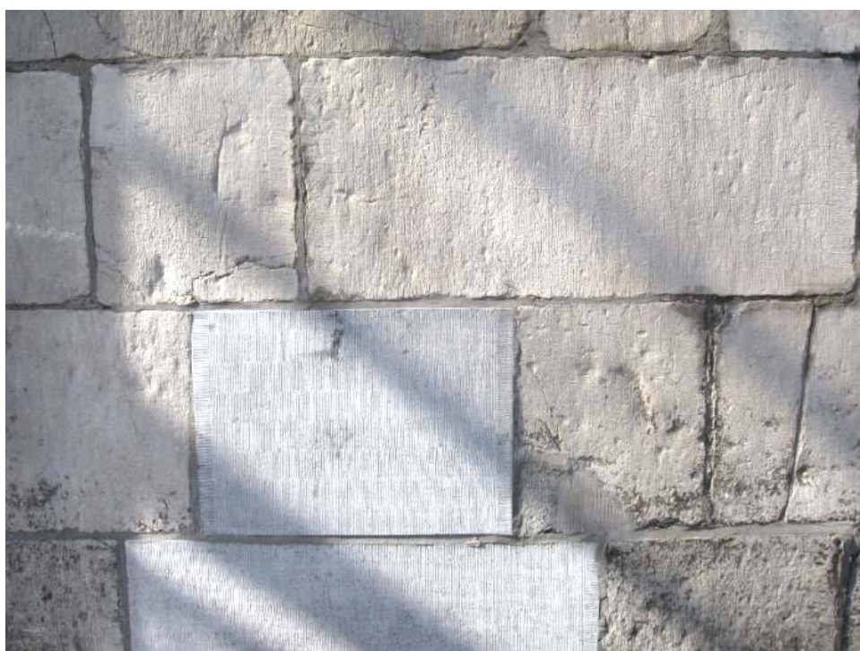
Imiteren. De oude blokken Naamse steen aan de gevel van het stadhuis van Maastricht zijn eerst met de hand vlak gemaakt en daarna pas gefrijnd. Recente vervangingen met Ierse hardsteen (midden en midden onder) zijn vlak gezaagd en daarna gefrijnd. Het eindresultaat sluit niet goed aan bij de oorspronkelijke omgeving, omdat het de onvolkomenheden van het handwerk mist en het materiaal anders is. Het gaat hier om een imitatie.
