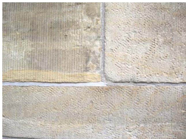
Imiteren. De blokken Obernkirchner zandsteen aan de voorgevel van het stadhuis van Leiden laten twee verschillende afwerkingen zien. De blokken die bij de herbouw na 1930 zijn geplaatst (rechts en onder) zijn anders bewerkt dan de blokken die gespaard bleven (linksboven). Op deze wijze is zichtbaar gemaakt welke steen is toegevoegd tijdens de herbouw.
