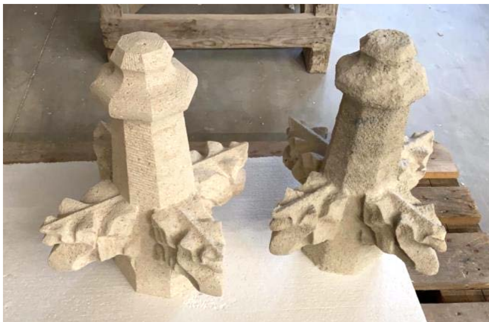
Imiteren. Deze kruisbloemen, die bestemd zijn voor de Domtoren in Utrecht, dateren van even na 1900 (rechts) en 2020 (links). De oude kruisbloem is van Reffroy (niet meer verkrijgbaar in 2020) en de nieuwe is uitgevoerd in Portland stone. Het gaat dus om een imitatie omdat een ander materiaal is gebruikt. Voor velen zal dit voorbeeld echter overkomen als een voorbeeld van kopiëren omdat vormgeving en afwerking wel sterk overeenkomen
