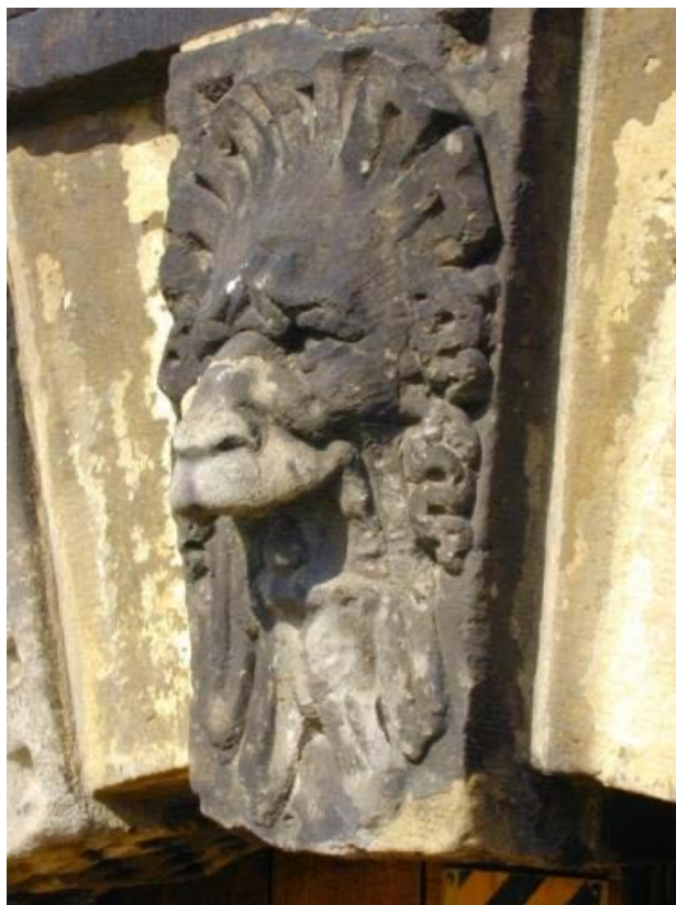
Repareren. Op minder zwaar belaste plekken is het gebruik van een mortel mogelijk, maar dan moet de ondergrond wel gezond zijn. Deze sluitsteen van Bentheimer zandsteen aan de trap van het stadhuis van Gouda is aangevuld met mortel (op de punt van de neus), die helaas na ongeveer tien jaar iets van zijn donkere kleur heeft verloren.
