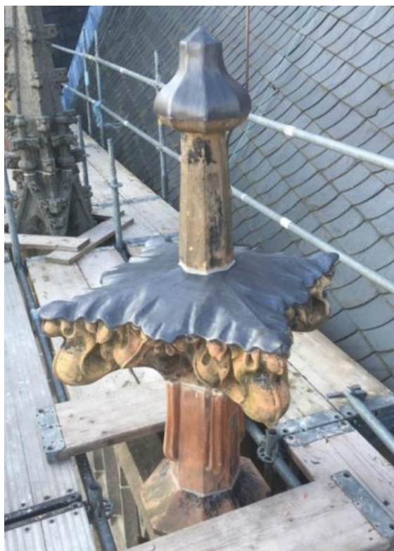
Conserveren. In dit geval geen natuursteen, maar een terracotta kruisbloem op de Domkerk in Utrecht die door een afdekking met lood wordt beschermd tegen weersinvloeden.
