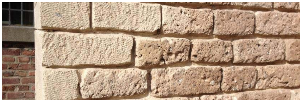
Imiteren. De paramentblokken aan de kerk van Hellendoorn waren van Römer tuf (rechts) en zijn deels vervangen door blokken Weiber tuf (links). De blokken Weiber tuf zijn afgewerkt met een tandijzer (links). Deze afwerking was niet aanwezig op de oude omgeving en is uitgevoerd om de nieuwe tufsteen visueel aan te laten sluiten bij de oudere omgeving.
