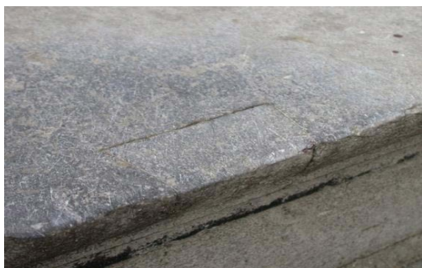
Repareren. Door middel van het inboeten van een traprede met een zwaluwtaartvormig stukje kan een reparatie gemaakt worden die zelfs op een zwaar belaste plek, zoals deze, het lang kan uithouden.
